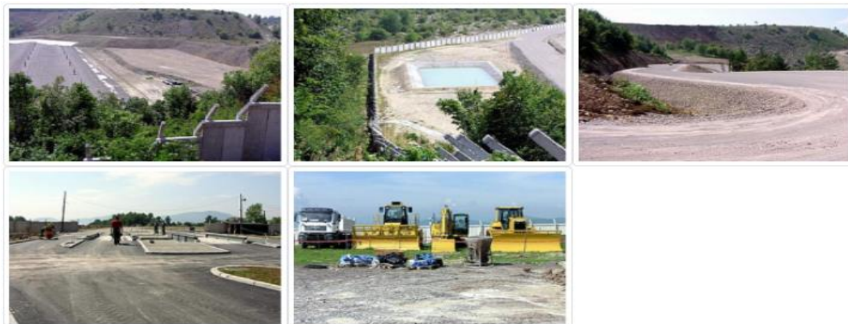
18. Sanitarna deponija Mošćanica Zenica
