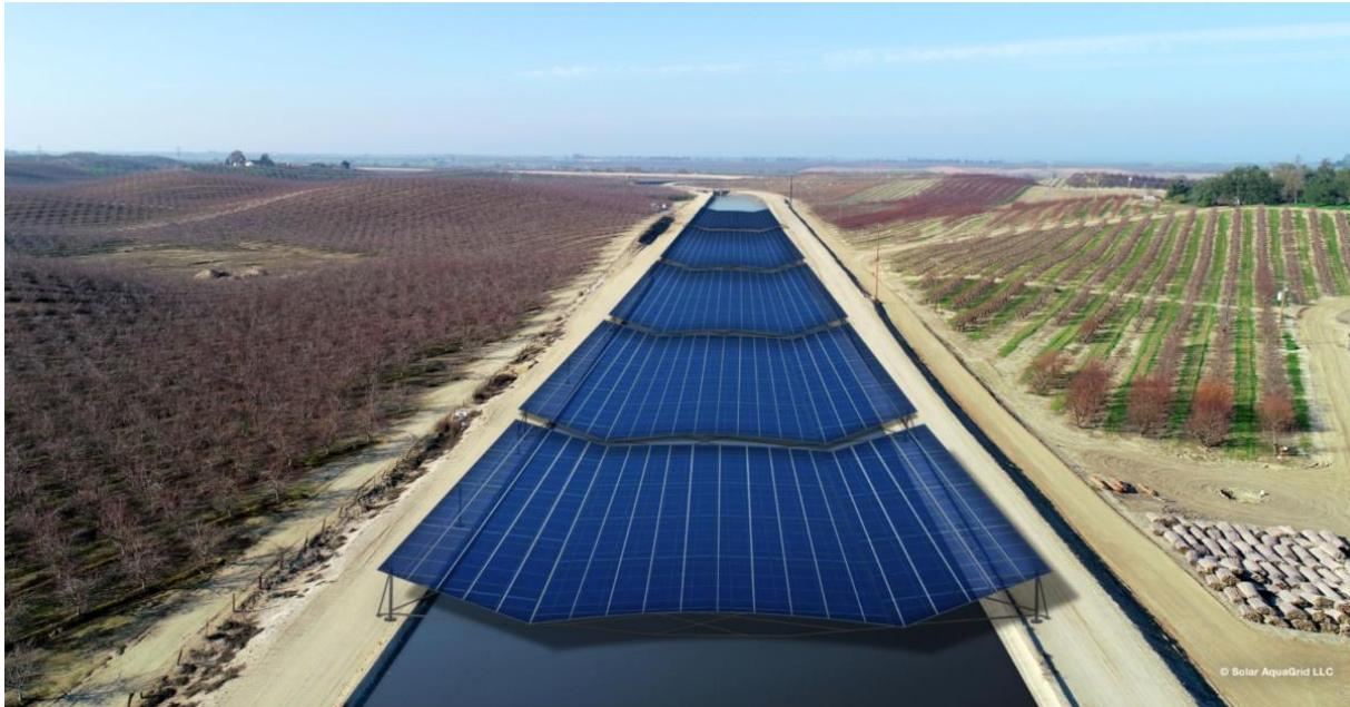
Grafički prikaz iz Studije solarnih panela iznad kalifornijskih kanala za navodnjavanje
