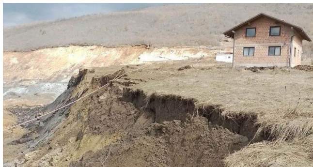
Slika 8. Prikaz zemljišta izazvanog nesvjesnim ili namjernim radom Rudnika uglja „Gračanica“ 152
